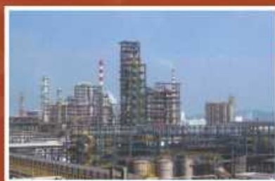
化工用管 Cracking pipe
